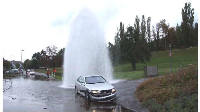
Die Wassersäule steigt meterhoch in den Himmel
