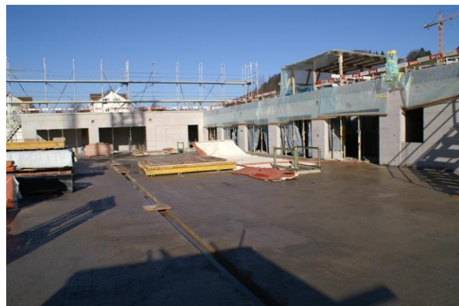
Einsatzzentrale, Führungsraum und Garderobennischen
