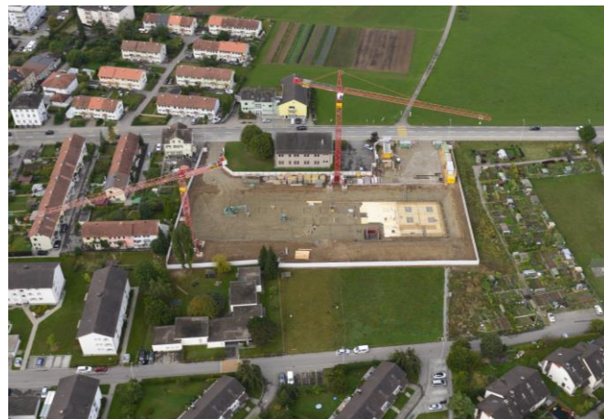
Luftaufnahmen von der Baustelle
