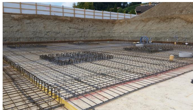
Beginn des Einbaus der Bodenplatten
