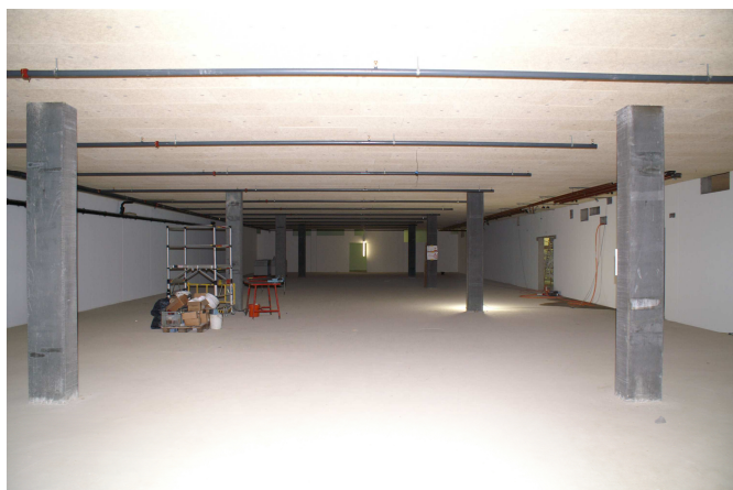
Lagerraum im Untergeschoss
