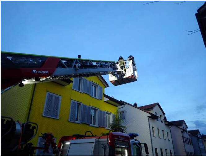
Mittels G4 werden die losen Ziegel entfernt
