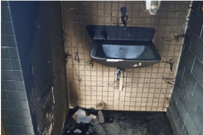
Brand in öffentlicher Toilette
