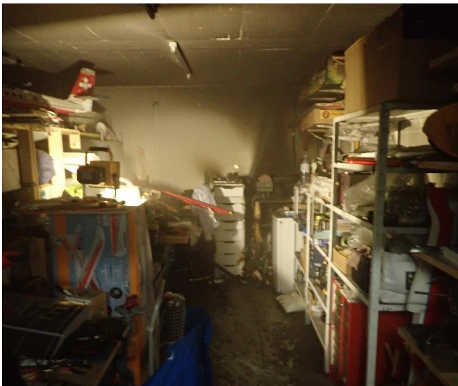
Enormer Rauchschaden durch Modell-Akku
