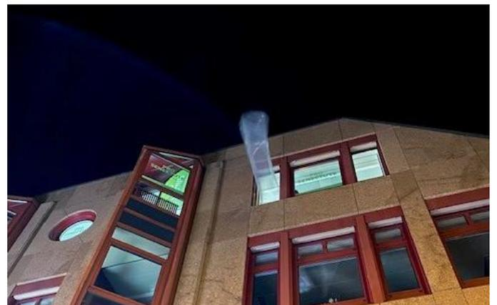
**Der Rauch wird mittels Plastiklutte abgeführt**
