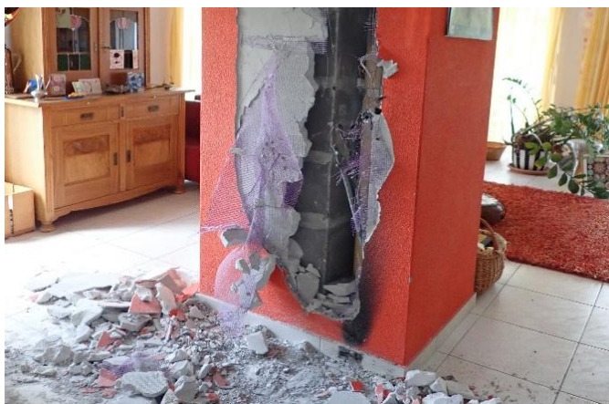
Die Wand zum Kanal musste aufgebrochen werden
