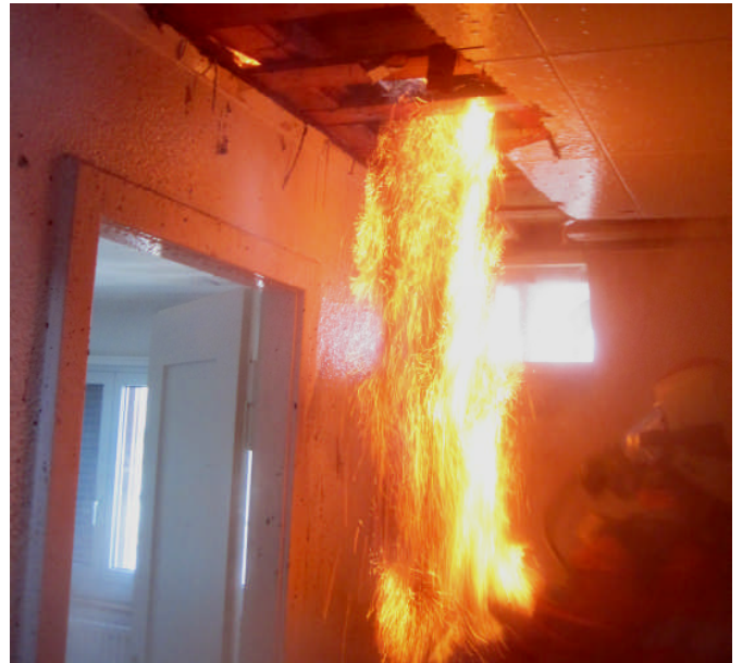
Glutnester in den Zwischenräumen der Decke
