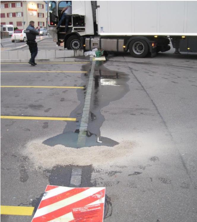
Die Magnetschachtabdeckung kommt zum Einsatz.
