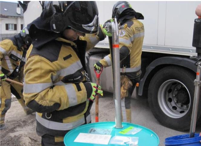
Mit der Fasspumpe wird der Tankinhalt umgepumpt.
