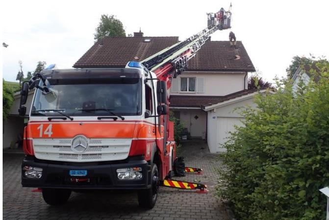
**Lose Ziegel werden befestigt oder entfernt**
