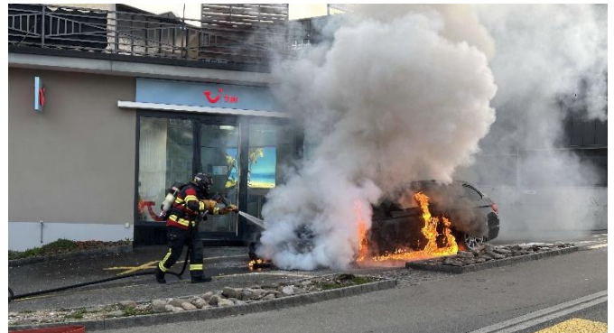
Fahrzeugbrand sehr nahe an Fassade Bild: Kapo SG
